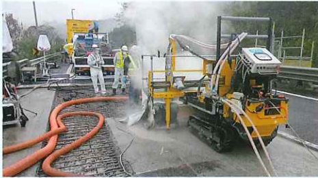
〔橋梁補修工事〕
