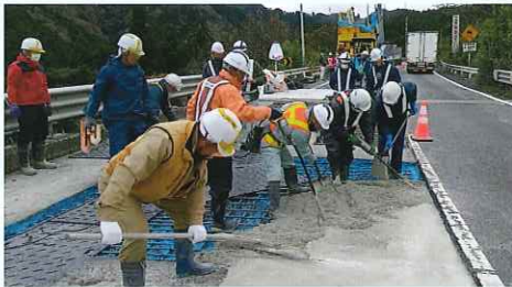
橋梁の舗装下のコンクリートを補修します。
