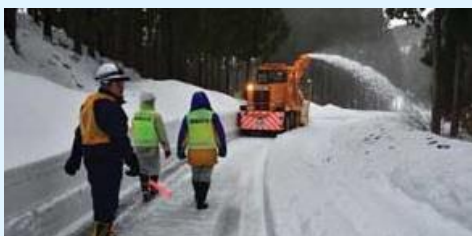
あわら市道におけるTEC-FORCEによる除雪 出典：国土交通省中部地方整備局HP
