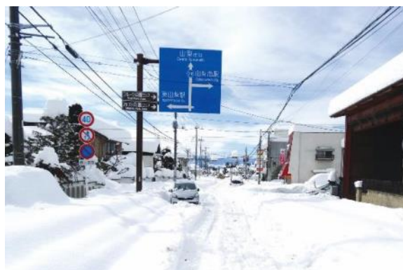
積雪により通行不能となった道路
