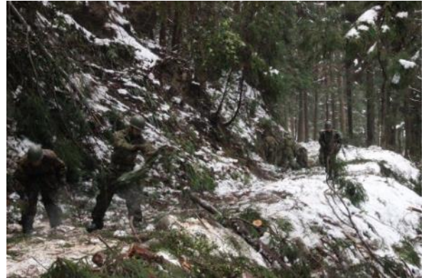
自衛隊派遣による孤立集落解消のための道路啓開対応の状況（平成26年12月8日、徳島県つるぎ町） 出典：防衛省HP
