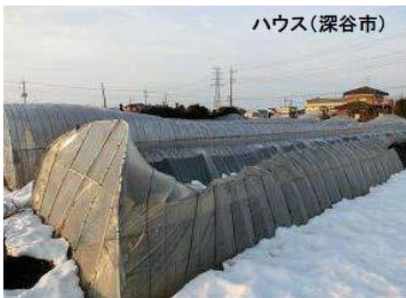
ビニールハウスの被害
